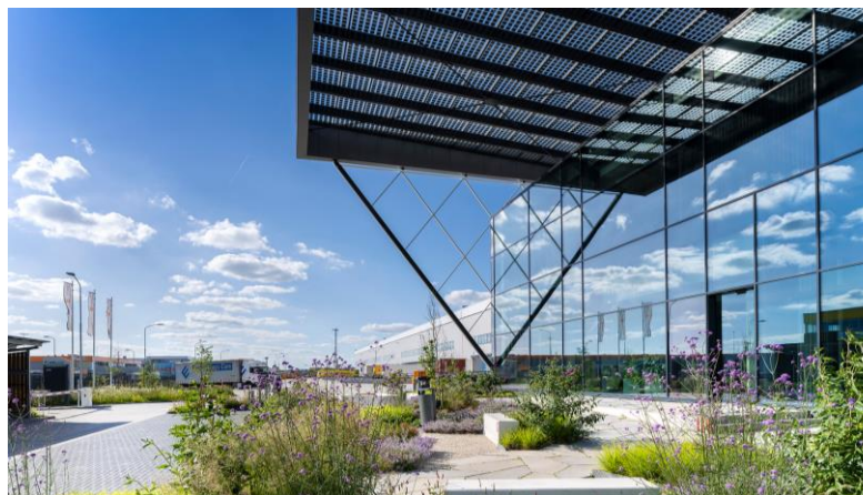
Open en transparante gevel met luifel. Bron: Prologis Eindhoven.
