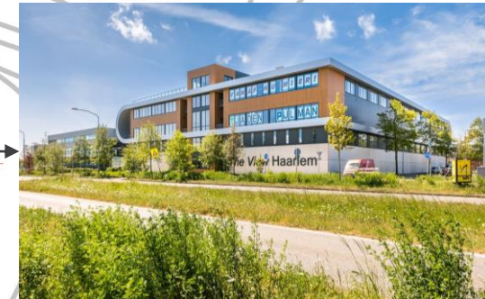
Meerlaags bedrijfsverzamelgebouw De View, Haarlem
