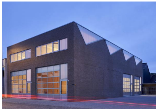
Verdichting en uitbreiding, Rozenburg
