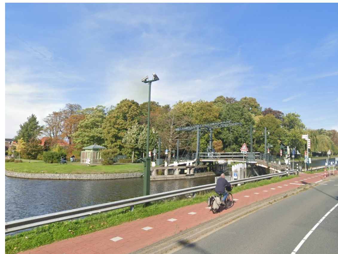
De Nieuwe Tolbrug gezien vanaf de Westvlietweg
