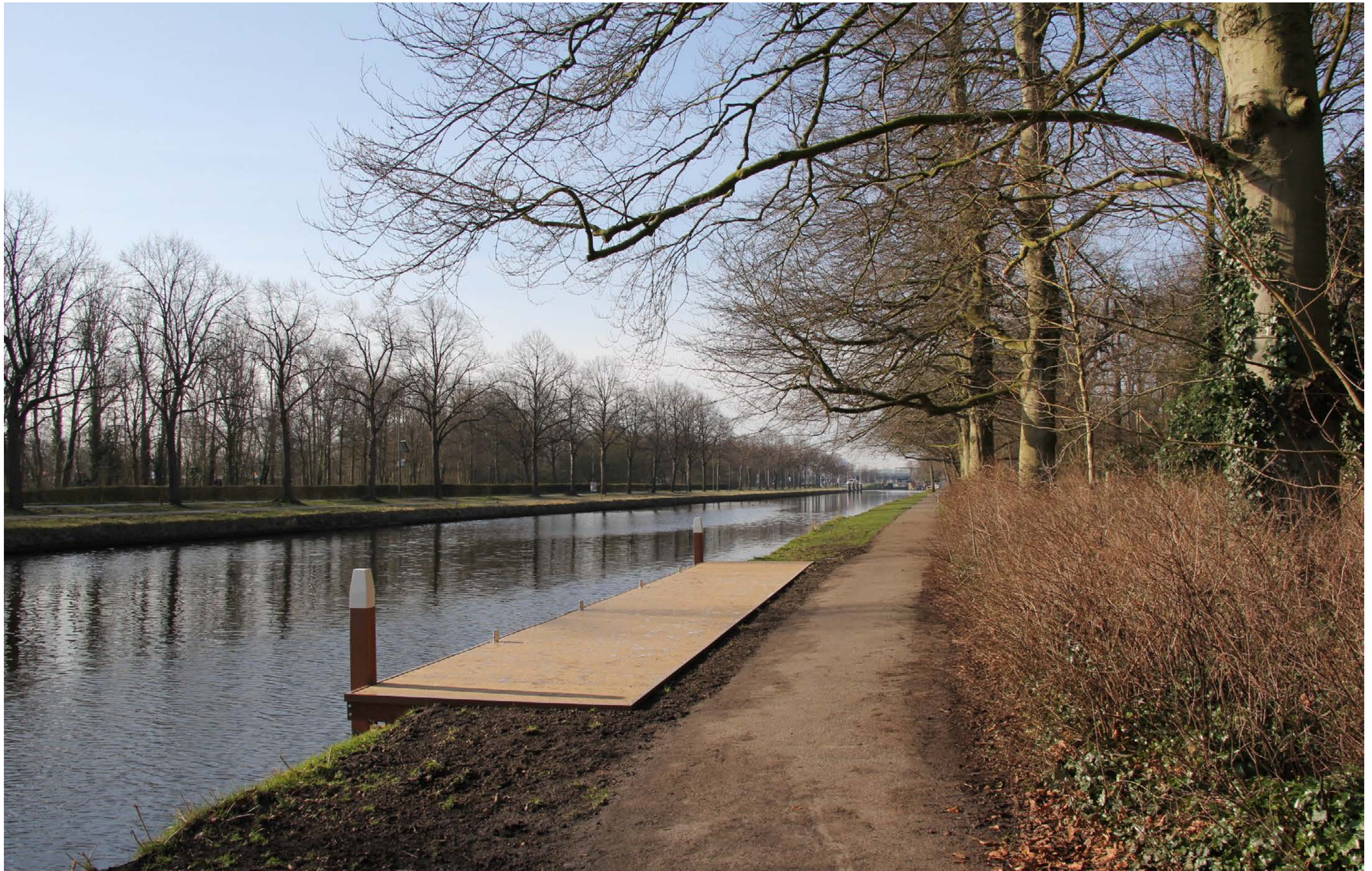
Nieuwe aanlegsteiger Vreugd en Rust
