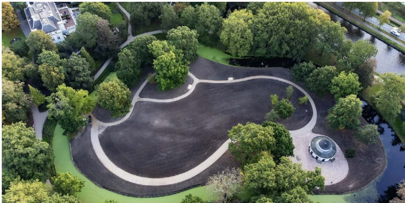
Restauratie in uitvoering: Park Vreugd en Rust te Voorburg (voormalige buitenplaats). Instandhoudingsplan Stichting in Arcadië, 2023; definitief ontwerp hertenkamp door Korneel Aschman Erfgoedadvies 2024.
