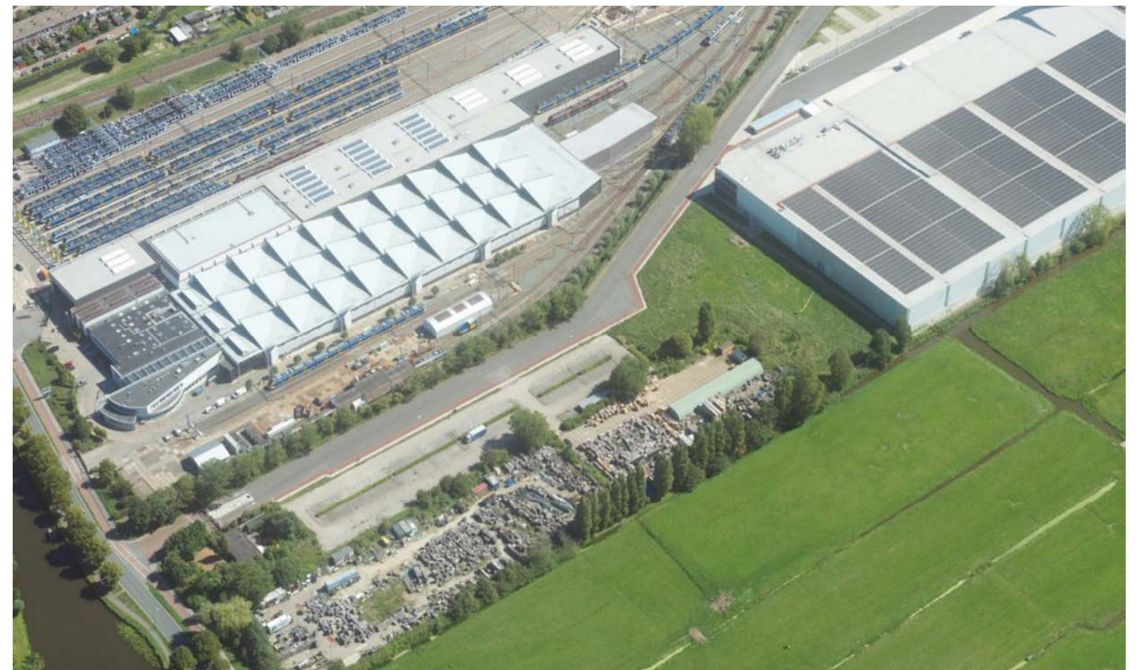
Spooreplacement en Treinreparatiecentrum NS met daarnaast gelegen bedrijfshal
